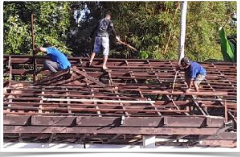
Renovatie van het dak van de STTEMA studentenhuisvesting
